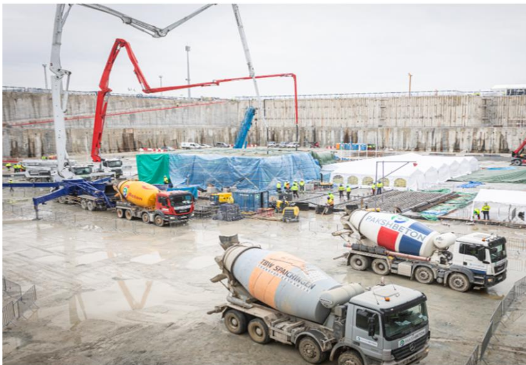
1. ábra: A Vezénylő épület alaplemez Bay 1.1 szakaszán az első beton öntése
